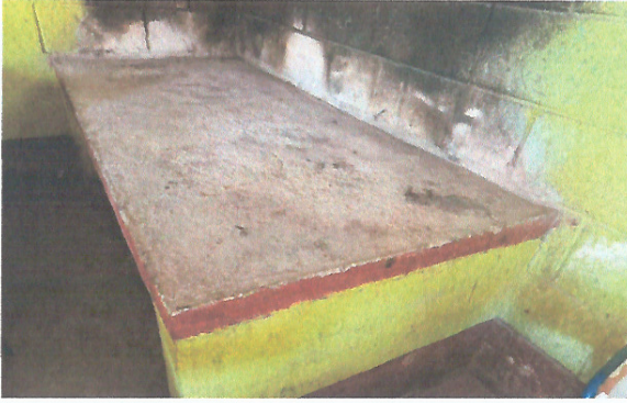
Foto 5: Mejoramiento de cocina (plancha de cocina, azulejo)
