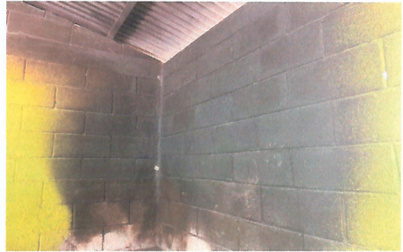
Foto 6: Mejoramiento de cocina (chimenea, pintura)
