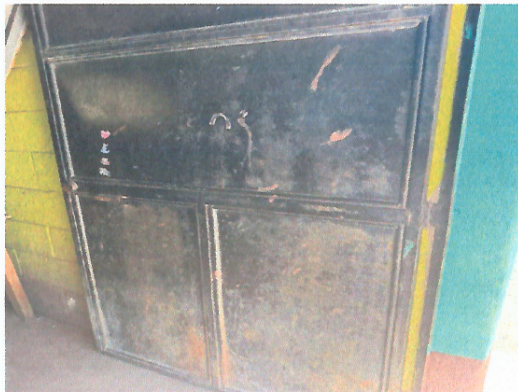
Foto 7: Mejoramiento de cocina (puerta)
