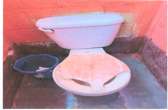
Foto 2: Mejoramiento de baños (cambio de sanitarios)
