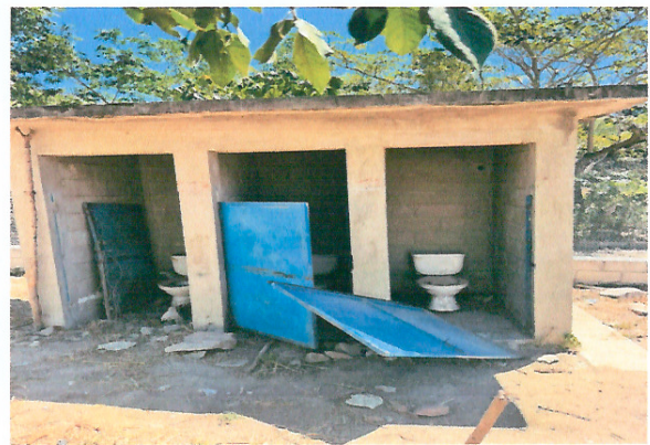
Foto 4: Mejoramiento de baños (cambio de sanitarios, puertas, pintura, lavamanos)
