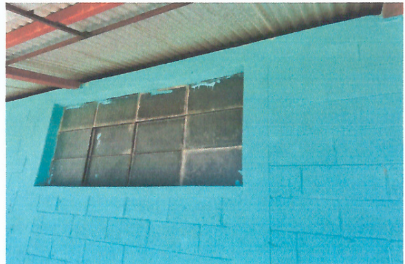
Foto 8: Mejoramiento de ventana (balcón)
