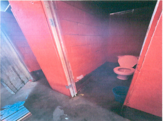
Foto 3: Mejoramiento de baños (puertas, pintura)
